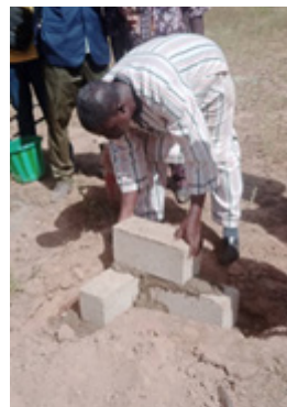
Pose de la première pierre
